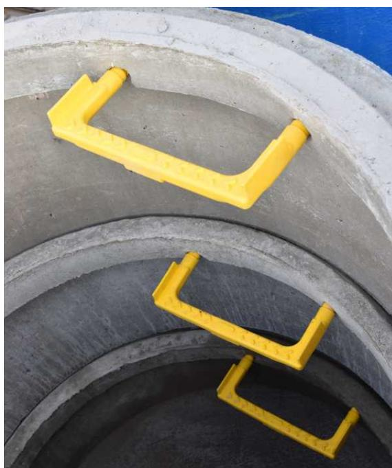
Os degraus para escada de serviço são usados para acesso a estruturas subterrâneas como poços de visita, bombeamento, bacias de retenção e tanques em geral, contando com um plástico extremamente resistente à corrosão.
